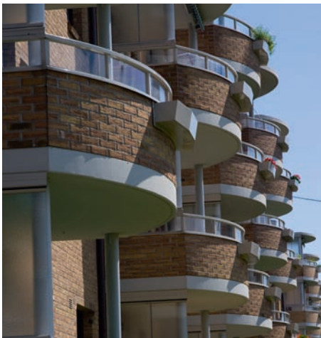
FORMER: Runde balkonger og vennlige fasader.
