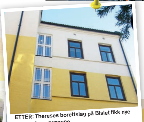
Thereses borettslag før rehabiliteringen.
