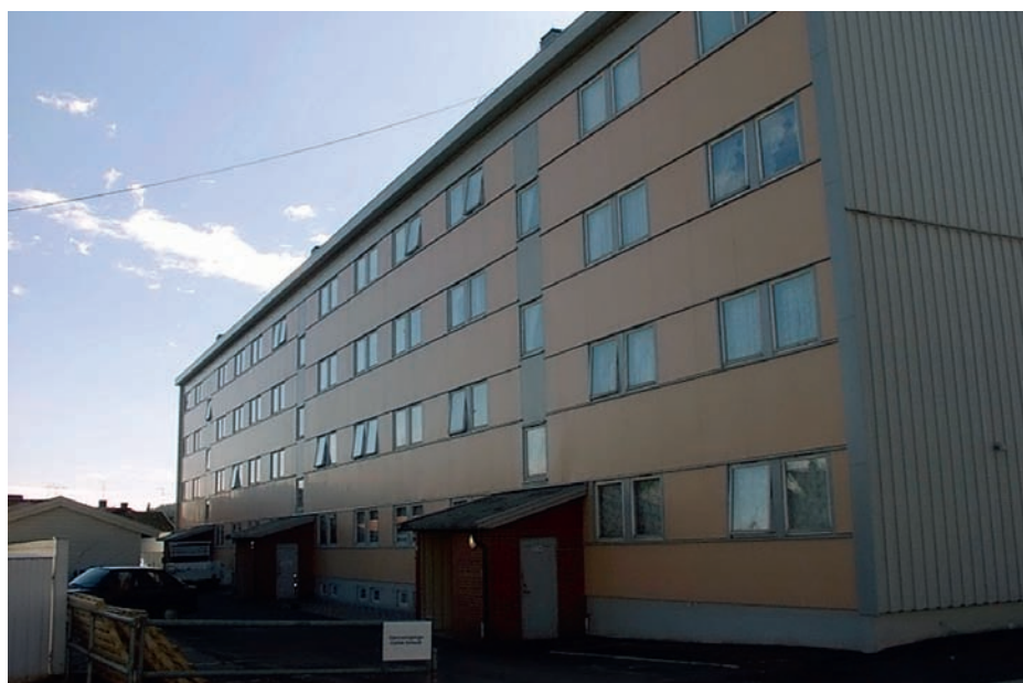
Slik så bygget ut før arbeidet med heisene ble påbegynt.
