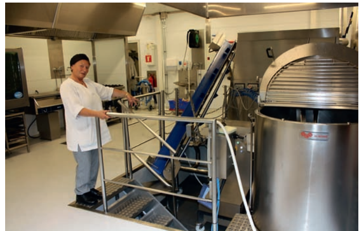
Tove Wrang viser hvor maten lages, og hvordan den sendes videre i et rørsystem til kjøleinnretningen.
