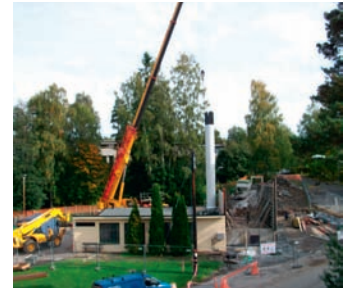
Den nye pipen heises på plass.
