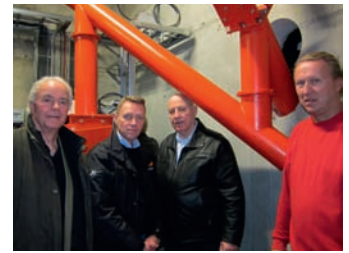
Prosjektleder fra Usbl, Stig Paugard, Geir Ove Roppaugen fra Bioenergy, styreleder Bjørn Hansen og vaktmester Tor Arne Adamsen i fyringsrommet ved siden av brenselrøret inn mot siloen.
