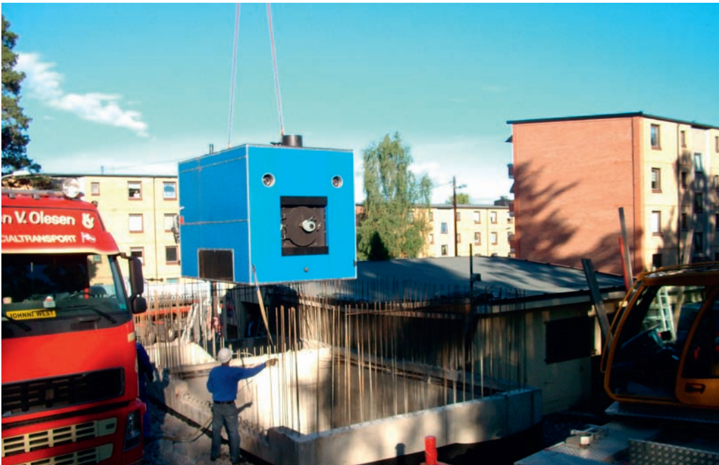
Den nye pelletsovn på vei ned i det utvidete fyringsrommet.
