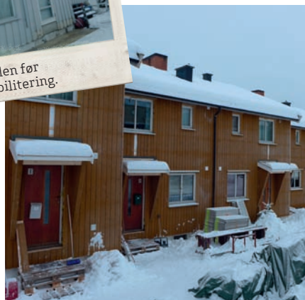
Her er fasadene endret på forsiden med ny fasadebekledning. Utskifting av vinduer og dører gjenstår.
