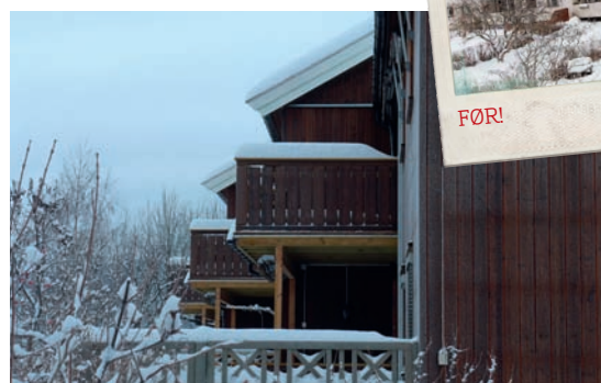
Borettslagene Åretta I og II har begge fått nye, utvidede balkonger. De nye balkongene er ca. en halv meter lengre enn de gamle.
