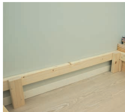
Et rammeverk av lekter festes i veggen.
