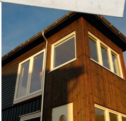
Huset etter ombygningen – med ny kledning.
