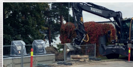
EnviroPac kan også levere grunnarbeider i forbindelse med installasjon av nedgravde avfallscontainere.
