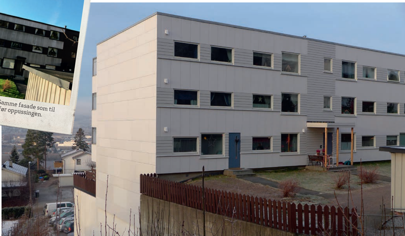
Ulike nyanser på veggplatene gir et fint spill i gavlveggene.
