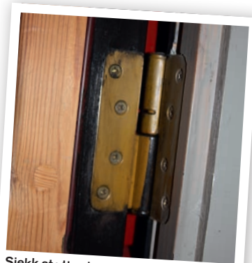
Sjekk at ytterdøren slutter godt inntil karmen. Justér lås og hengsler slik at døren blir tett.
